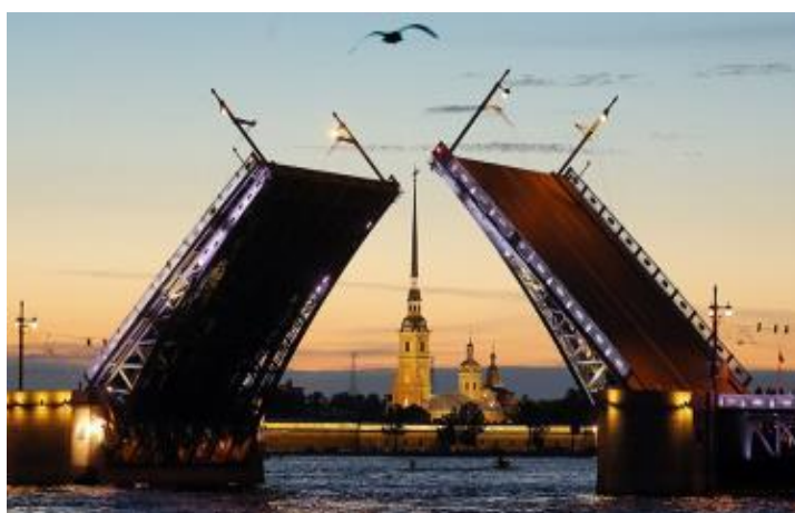
Дворцовый мост в Санкт-Петербурге, 1916 г.
